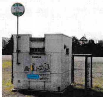
【写真】緊急貯水槽の上屋
